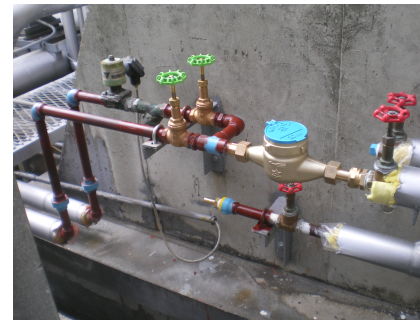
●冷却塔用メーター(補給水)
